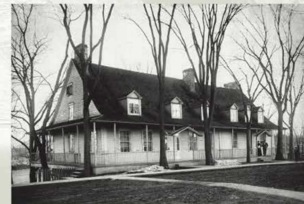
Prise vers 1900, cette photo montre le bâtiment où l'on retrouvait le magasin général Cartier jusqu'en 1876. Source de la photo : Centre d'histoire de Saint-Hyacinthe inc. (Centre régional d'archives et de généalogie)
